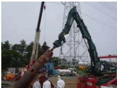
図 試験施工状況
