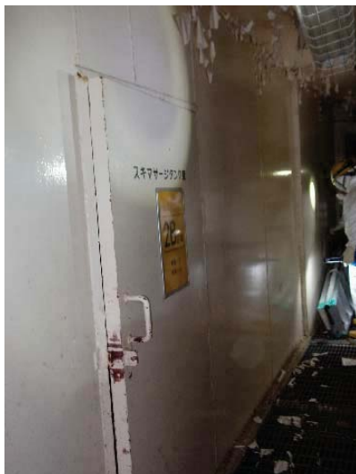
スキマサージタンク室扉
