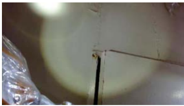
スキマサージタンク室扉を開け線量測定
