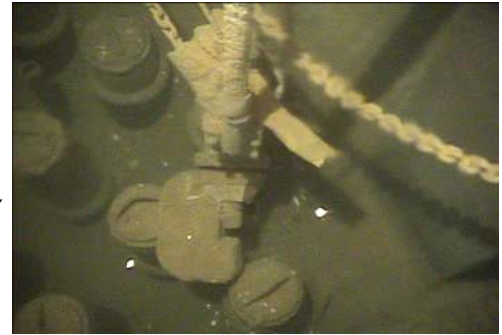
シュラウド取り替え工事関連機器
