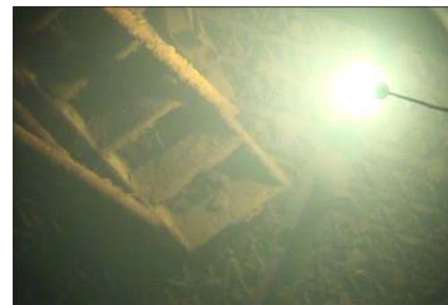
SFP内の作業台車梯子(ガレキ)
