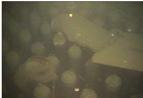
原子炉圧力容器底部のガレキ
