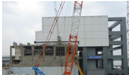
⑤ 西面（外壁）
