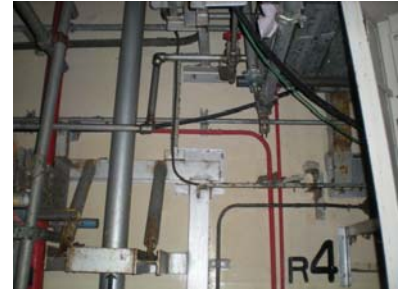
④ 西面（内壁）
