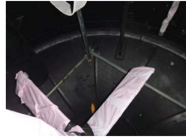
バッチ処理タンク2C (ゴムライニング施工後)
