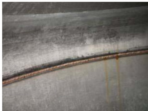
吸着塔13A タンク内上部溶接部 (若干の腐食あり)
