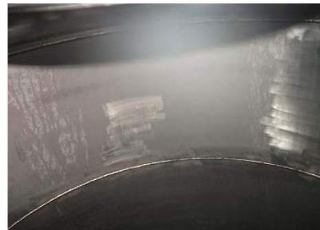
吸着塔2A タンク内上部溶接部（腐食なし）
