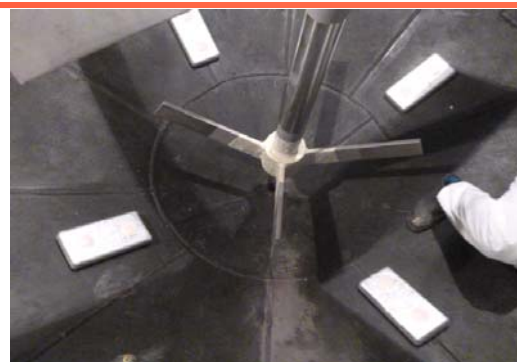
バッチ処理タンク1C （ゴムライニング施工後）
