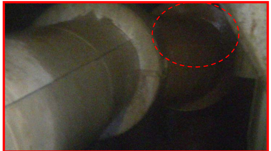
OP.5,900付近: 上部より水が落ちていることを確認
