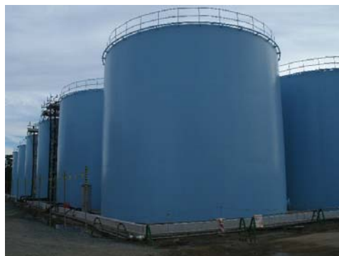
鋼製円筒型タンク（溶接）
