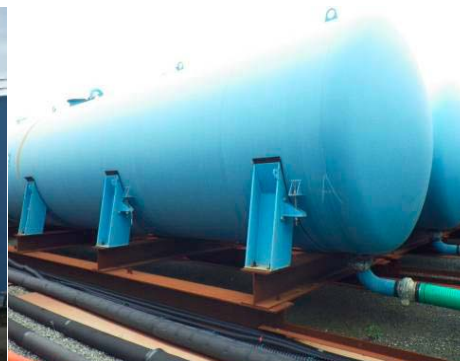
鋼製横置タンク
