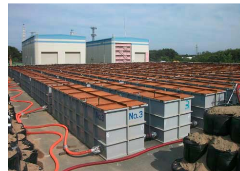
鋼製角形タンク
