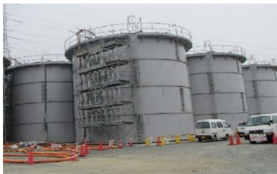
鋼製円筒型タンク（フランジ）
