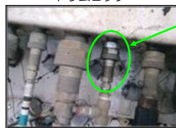
組立分解用ねじ式継手
