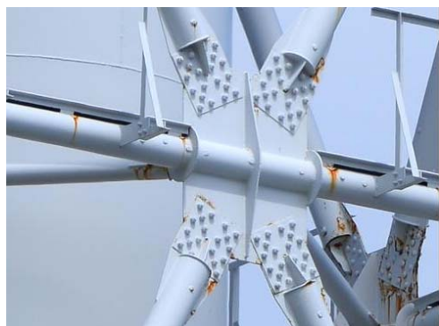
① 南側 (GL100m付近) 接合部
