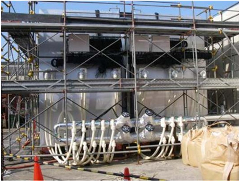
2013. 10. 31 メイン配管断熱材設置
