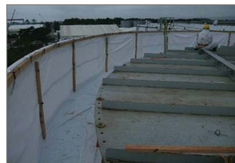
タンク歩廊部
