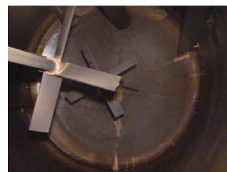
バッチ処理タンク2Aの点検状況
