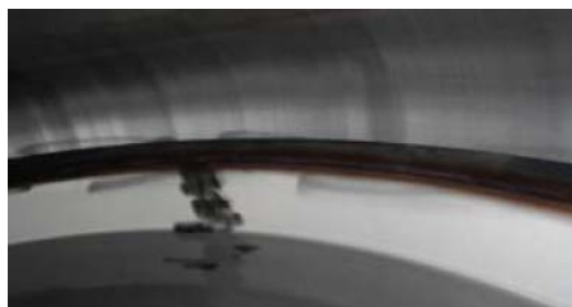
⑨吸着塔2C溶接線
