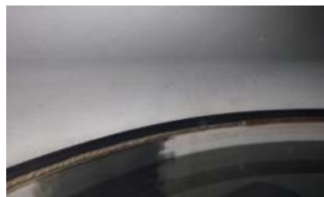
⑩吸着塔7C内部溶接線
