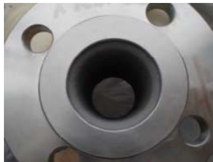
⑧供給ポンプ2出口配管フランジ
