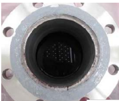
⑩吸着塔7C点検口
