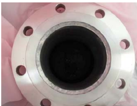
⑨吸着塔2C点検口
