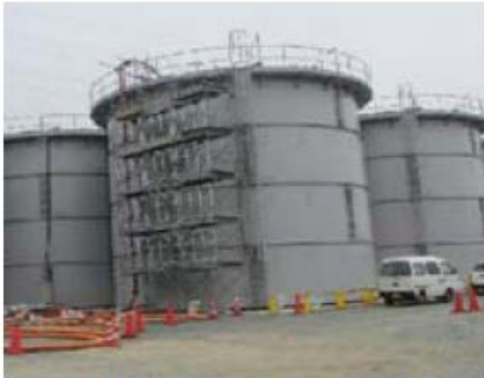
鋼製円筒型タンク(ボルト締め)
