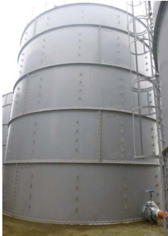
【鋼製フランジ型タンク】
