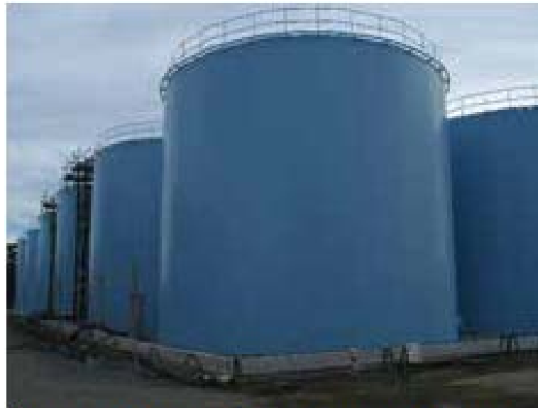
鋼製円筒型タンク（溶接）
