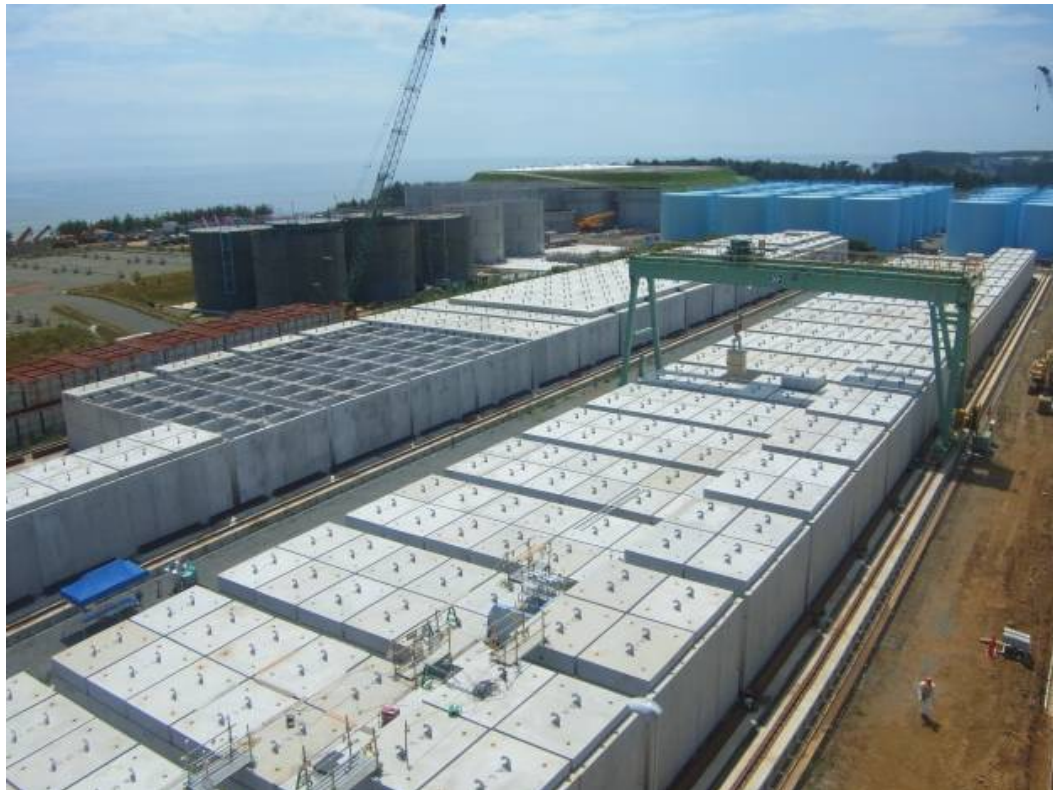
【セシウム吸着塔及び高性能容器一時保管施設】
