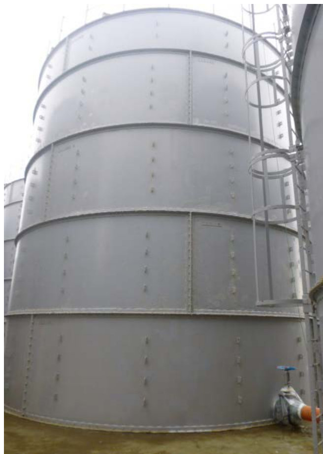
【鋼製円筒型タンク(ボルト締め)】
