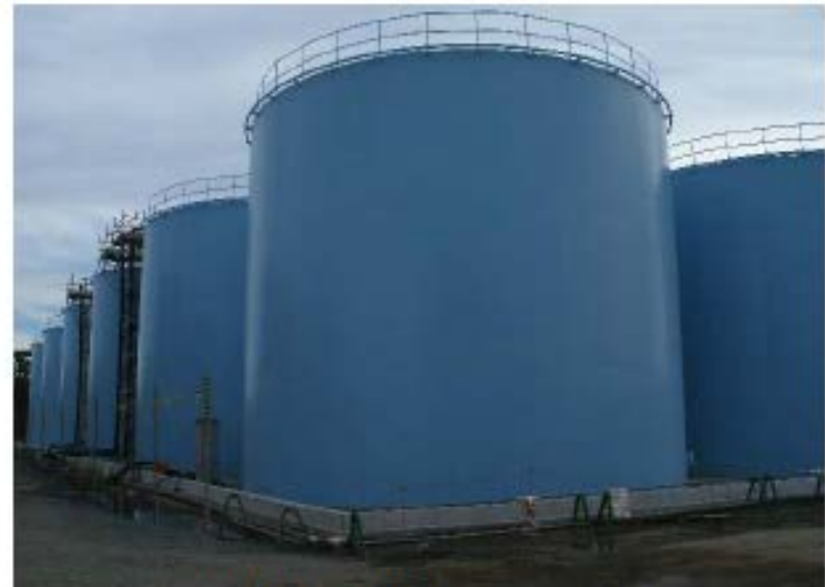
鋼製円筒型タンク(溶接)
