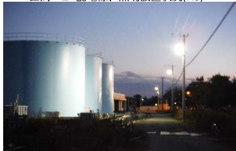
区間-E エリア照明点灯状況(H8)
