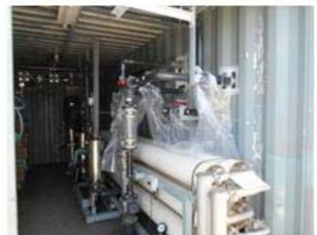
モバイルRO装置コンテナ内
