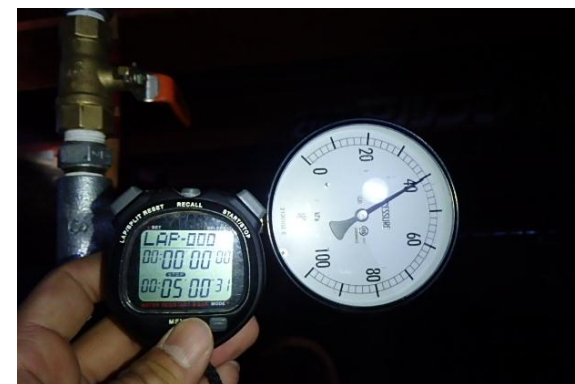
封入圧力確認状況
