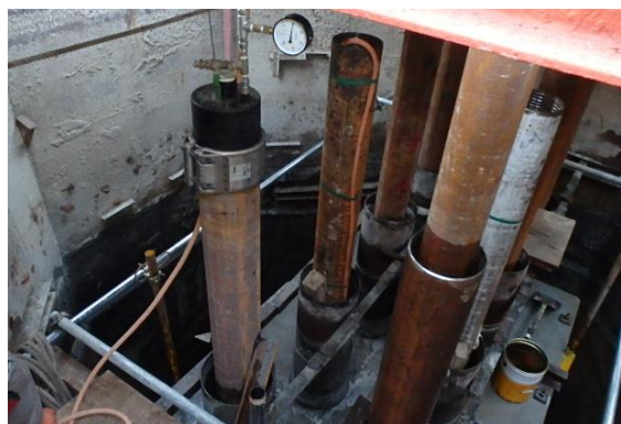
封入試験状況
