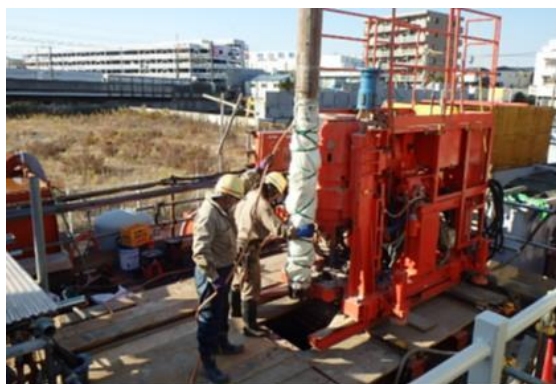
パッカー建込み状況
