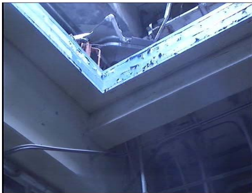
① 3F大梁交差部
