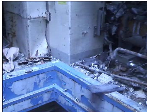
⑦ 3F柱脚部及びび床上状況
