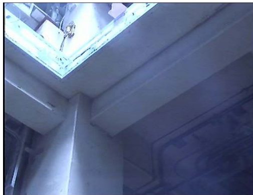
② 2F柱、3F大梁交差部
