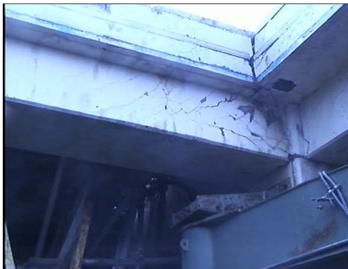
⑩ 4F柱、5F大梁交差部
