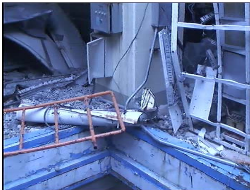
⑪ 4F柱脚部及び床上状況
