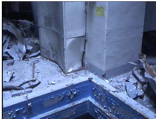
③ 2F柱脚部及びび床上状況
