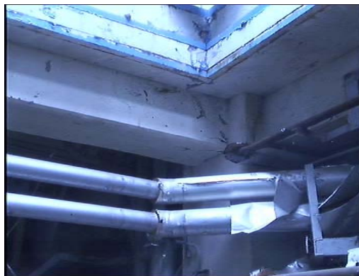
⑥ 3F柱、4F大梁交差部
