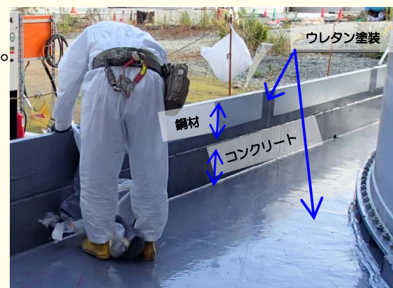
＜鋼材による嵩上げ状況＞
