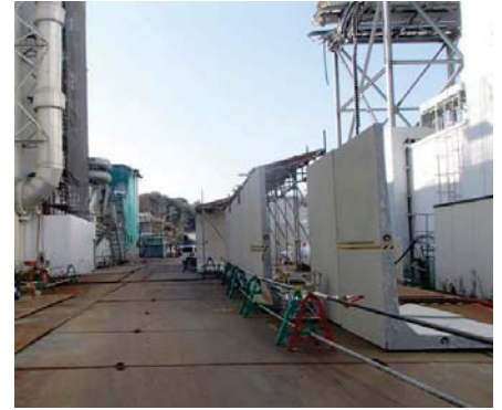
② 2号開削ダクト現況
