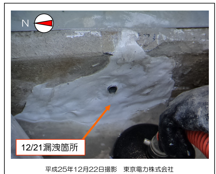
【H5タンクエリア西側堰のシール補修状況】
