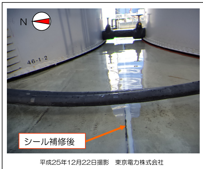
【H5タンクエリア堰内のシール補修状況】
