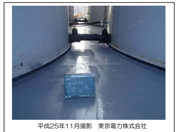
【保護舗装実施後のH2南タンクエリア】
