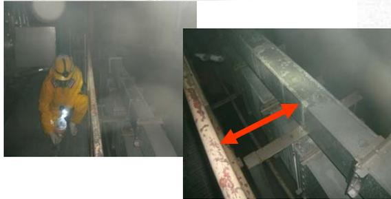
作業エリア確認(干渉物確認、装置設計のための寸法測定等)は、人が現場に立ち入りメジャー等で実測
