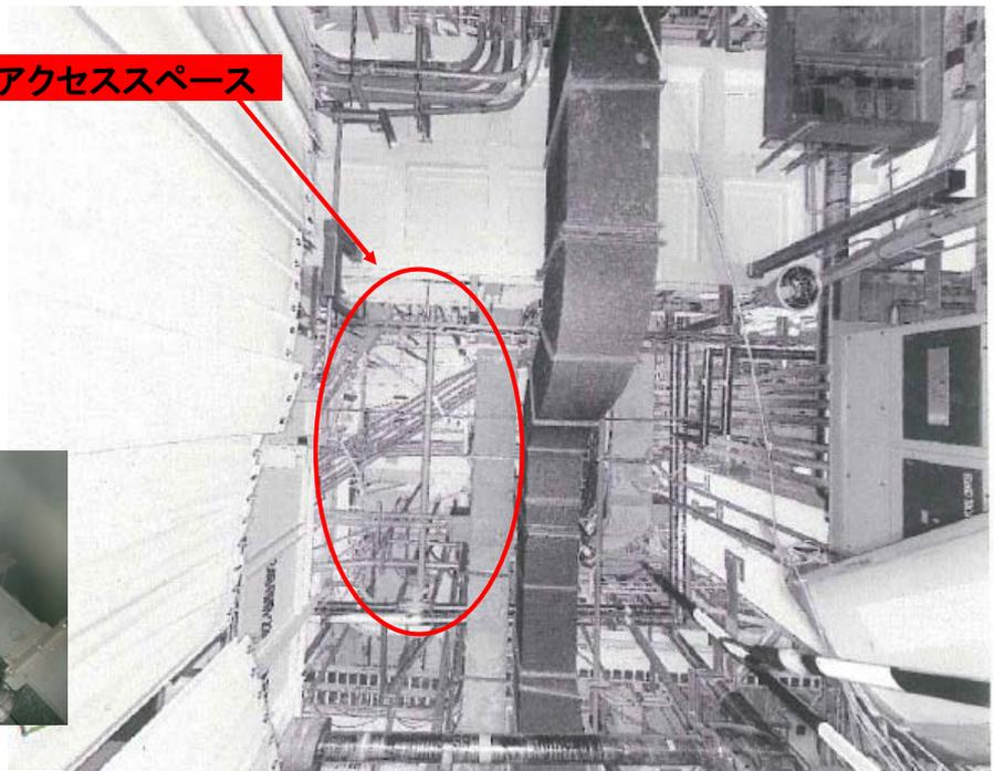
レーザスキャンで取得した計測データから、設備を明確に識別・計測
