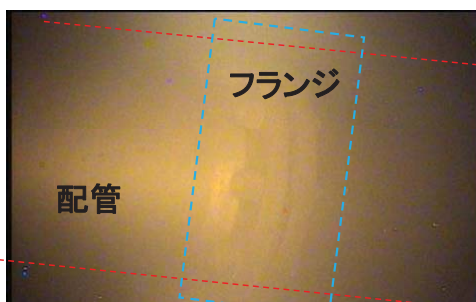
② 10B配管(水中部)
