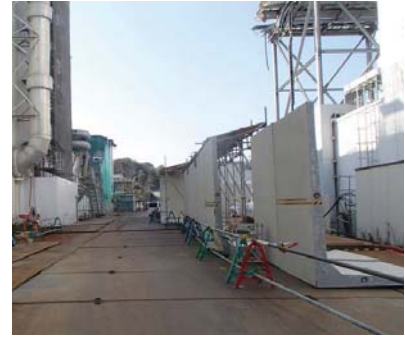
② 2号開削ダクト現況
