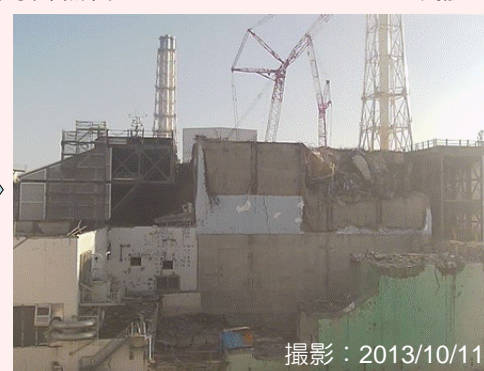
大型ガレキ撤去後
