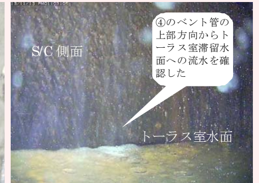
サンドクッションドレン管及びベント管上部からの漏水状況
