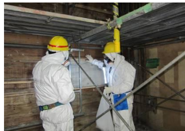
2階における使用済燃料プール底部に設置した支持構造物による補強の確認の様子。（4月23日）
