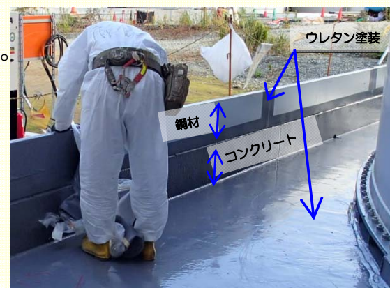
<鋼材による嵩上げ状況>
