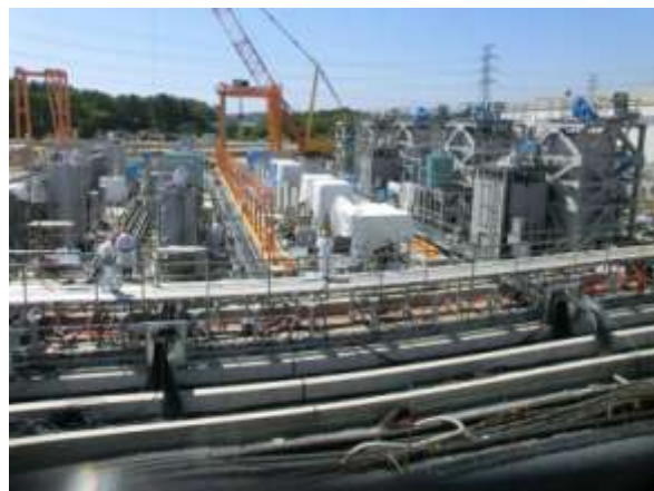
＜多核種除去装置(建設中)＞
