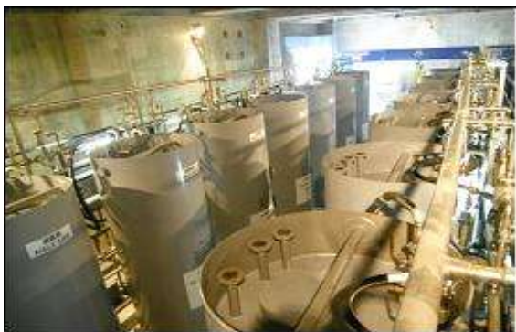
＜セシウム除去装置(稼働中)＞
