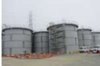
＜大型鋼製丸形タンク＞
