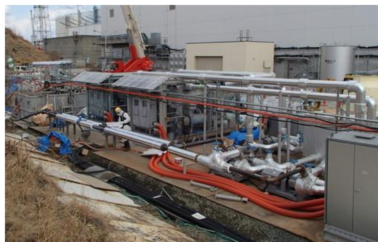
プラント設備
