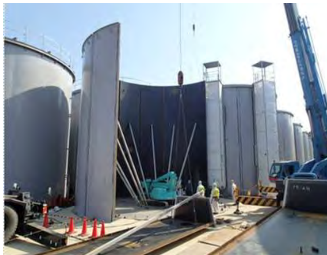
溶接型タンクの現地施工状況
