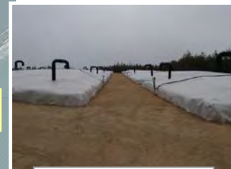
伐採木一時保管槽
