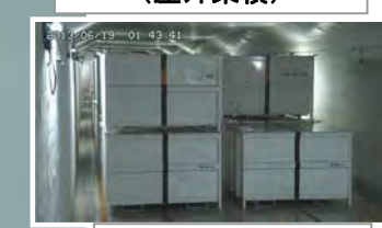
固体廃棄物貯蔵庫
