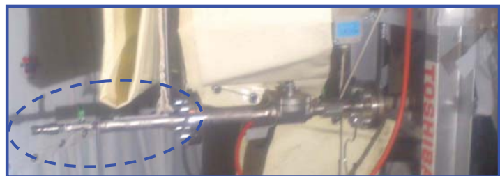
温度計ハウジング取り外し後、仮ハウジング設置
