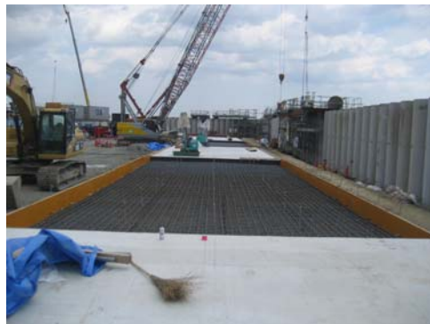
写真④ ライン③基礎状況
