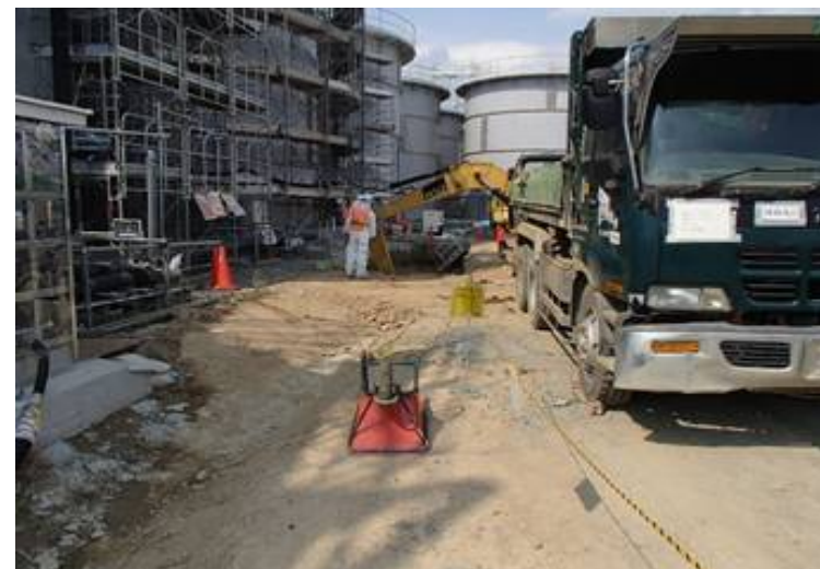
汚染土の掘削(H6エリア)
