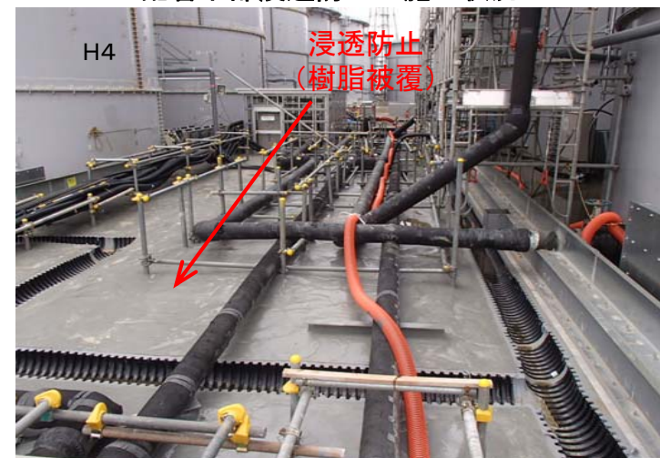
配管下部浸透防止工施工状況
