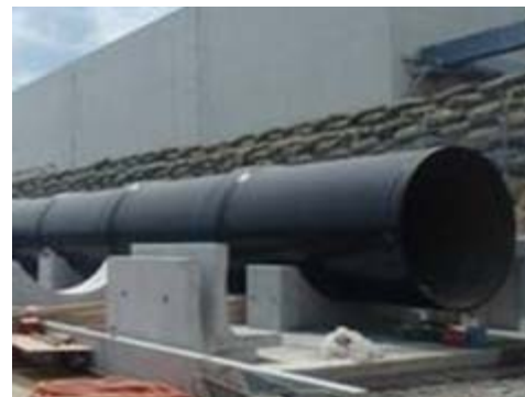
写真③ ライン②排水管据付状況
