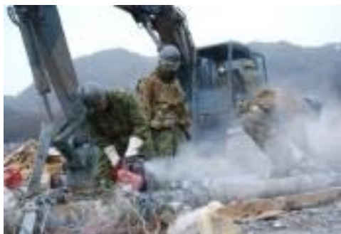
道路啓開作業
