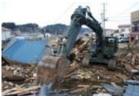
倒壊家屋の除去作業
