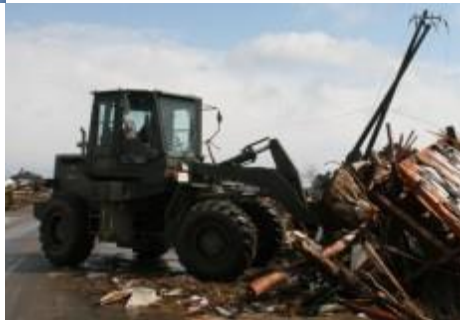
道路啓開作業
