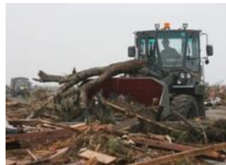
バケットを使用し がれきを除去
