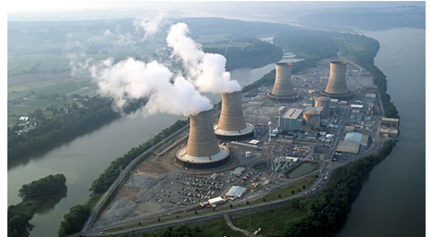
スリーマイル島原子力発電所
