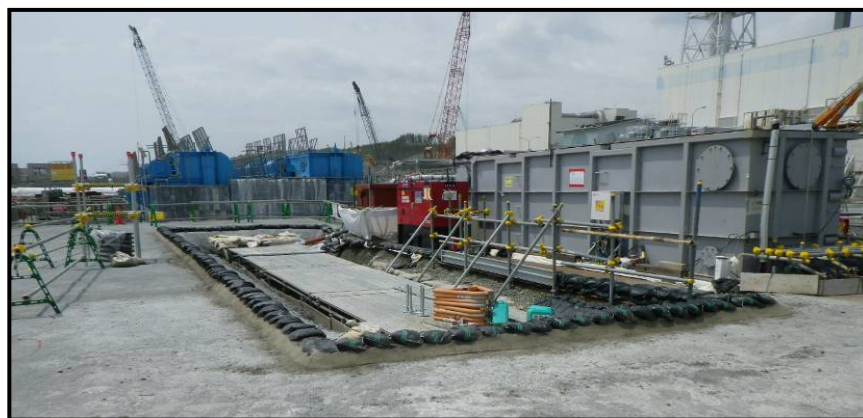
雨水浸透防止対策の実施状況 (3～4号機間の例：H26.5.23撮影)
