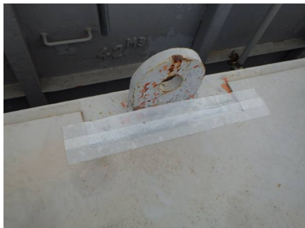
雨水侵入防止状況
