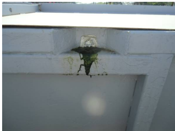
漏えい箇所 (No1-5)
