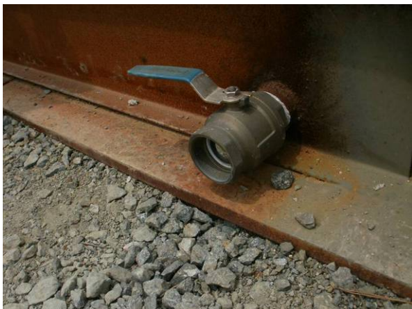
ドレン弁の状況
