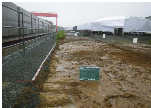
土壌回収状況
