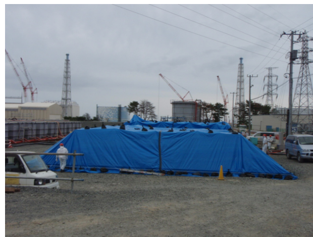
堰カバー設置状況 (3,000トンノッチタンク群)
