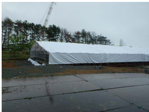
堰カバー設置状況 (1,000トンノッチタンク群)
