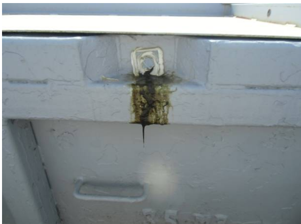
漏えい箇所 (No1-3)
