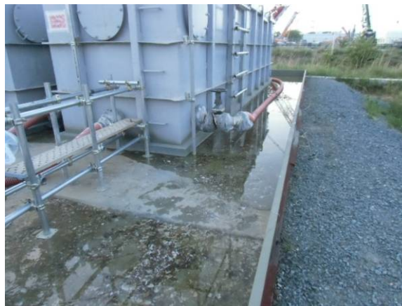
ノッチタンク堰内の状況
