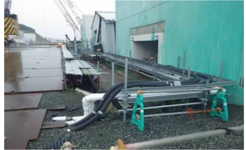
移送配管敷設状況（1号機東側）
