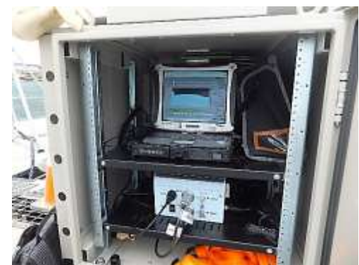
キャビネット内部の計測機器
