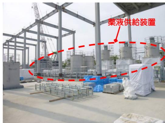
図3：増設多核種除去設備 機器据付状況
