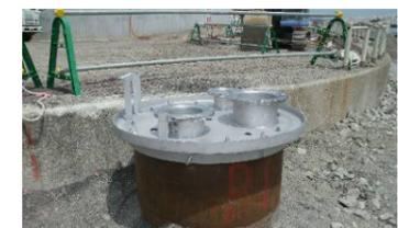
地下水ドレン汲み上げ用井戸設置状況（1号取水口前）
