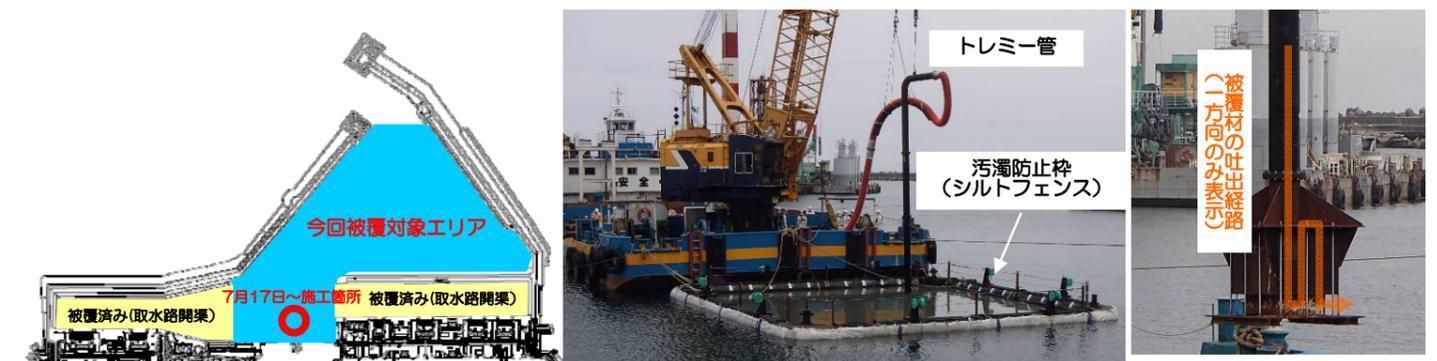
図9：港湾内海底土被覆工事の作業状況
