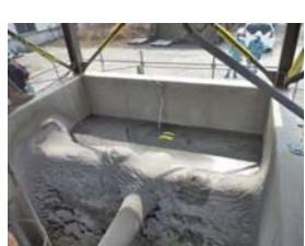
写真30-5 止水材の打設完了
