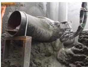
写真30-1 配管周囲の堰構築
