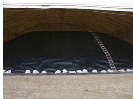
1 槽目内部の状態 (H24/12/13)
