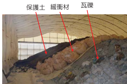
1 槽目内部の状態 (H24/11/1)
