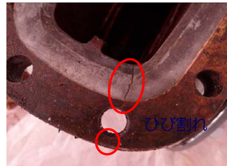
ガスケット取り外し後
