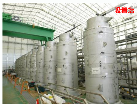
<高性能多核種除去設備 設置状況>
