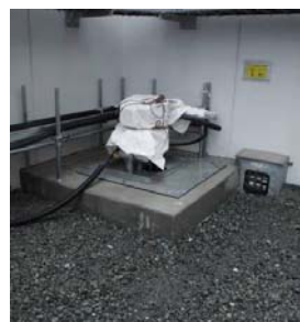
サブドレンピット
