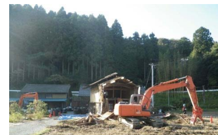
楢葉町における 家屋解体の状況 (平成26年10月)
