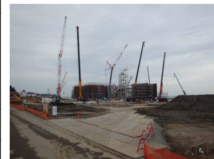
富岡町における 仮設焼却施設の建設状況 (平成26年10月)
