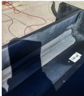
塗装剥離後の一例
