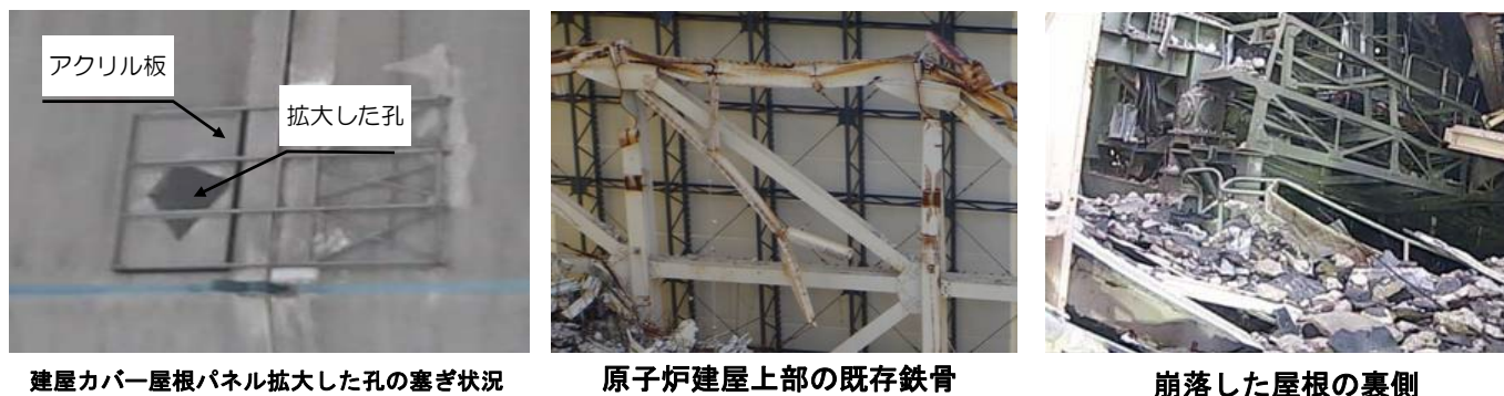
図9: 1号機原子炉建屋上部 屋根パネル孔塞ぎ状況およびガレキ調査状況
