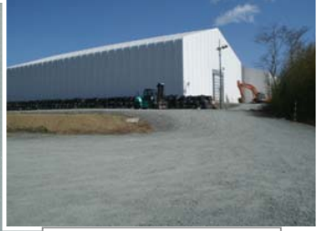
瓦礫保管テント
