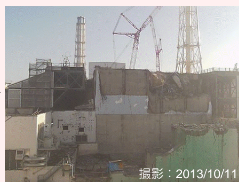
大型ガレキ撤去後
