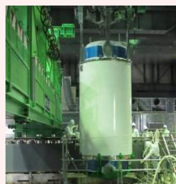
燃料取り出し状況
