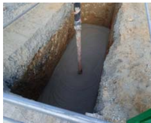
①モルタル置換完了 ②モルタル置換施工
