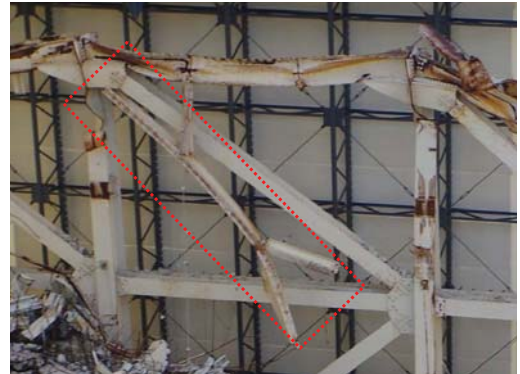
⑥ 西面10a通りの付近上部鉄骨損傷
