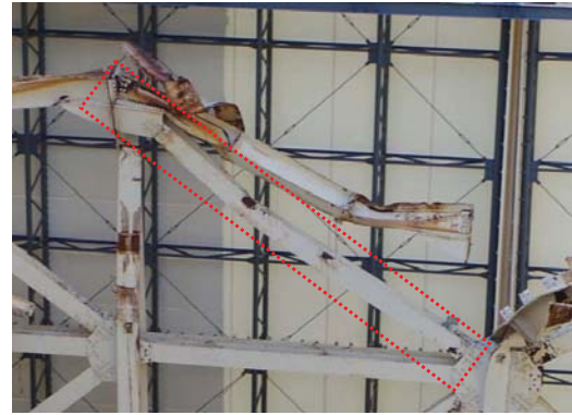
④ 9a-8a通り間上部鉄骨損傷
