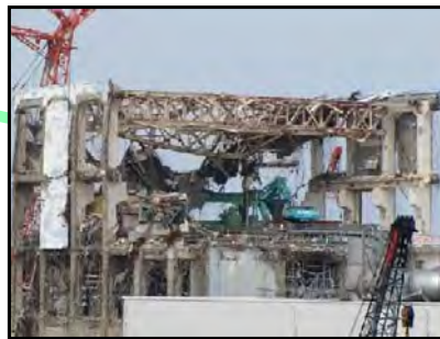
②撤去作業中の様子 (撮影日：平成24年5月28日)
