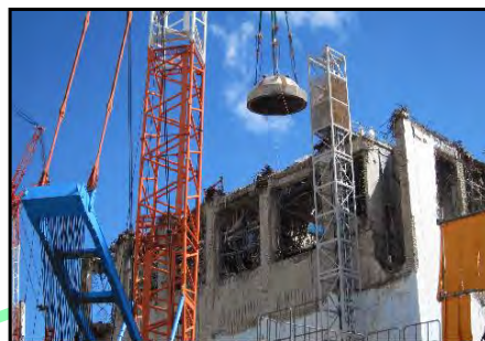
⑤圧力容器上蓋の撤去 (撮影日：平成24年9月13日)
