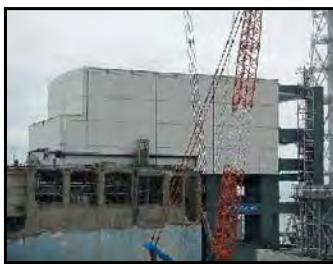
⑦外壁・屋根パネル設置完了 (撮影日:平成25年7月20日)
