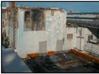
①鉄骨建方着工前 (撮影日:平成24年12月18日)
