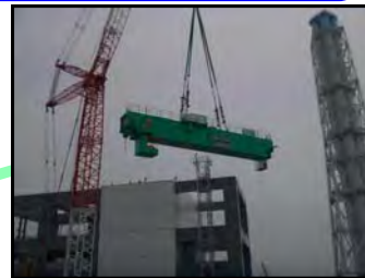
⑤クレーン部材吊り上げ (撮影日:平成25年6月7日)
