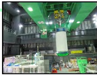
①キャスクを使用済燃料プールへ移動 (撮影日:平成25年11月18日)
