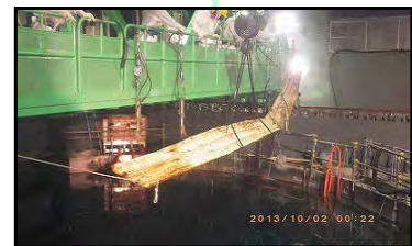
①大型ガレキの撤去 (撮影日:平成25年10月2日)
