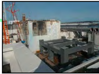
②第一節 鉄骨建方完了 (撮影日:平成25年1月14日)
