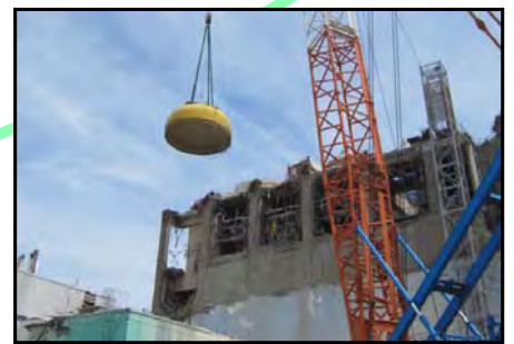
④格納容器上蓋の撤去 (撮影日：平成24年8月10日)
