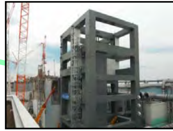
③原子炉建屋上部を除く鉄骨建方完了 (撮影日:平成25年4月10日)
