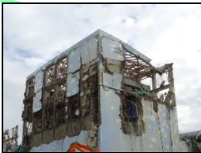
①ガレキ撤去前 (撮影日：平成23年9月22日)
