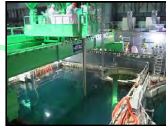
③燃料取り出し作業 (撮影日:平成25年11月18日)
