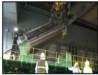
⑥トレーラーへの積み込み (撮影日:平成25年11月21日)
