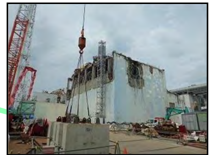
③撤去作業終了後 (撮影日：平成24年7月5日)
