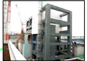
④鉄骨建方完了 (撮影日:平成25年5月29日)
