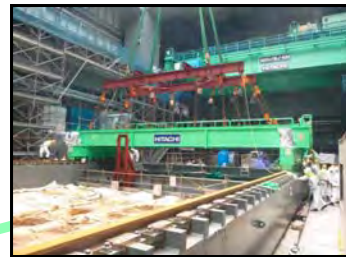
⑥燃料取扱機 部材据付け (撮影日:平成25年7月10日)
