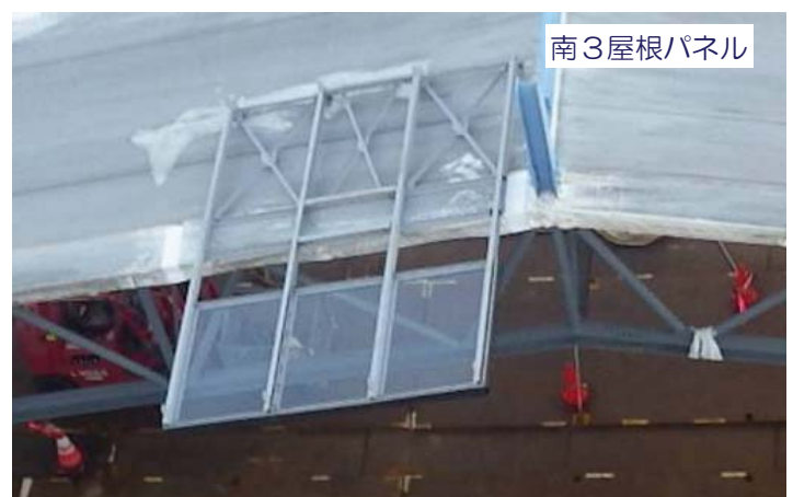
はね出し部材取り付け状況
